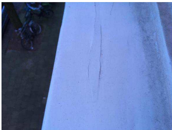
scheurvorming
