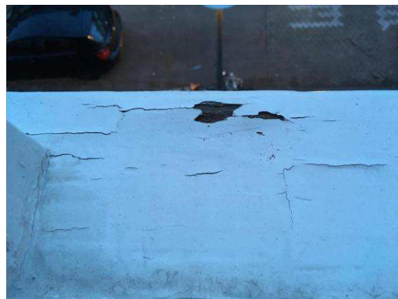
verweerd hout, scheurvorming en ondeugdelijke reparaties
